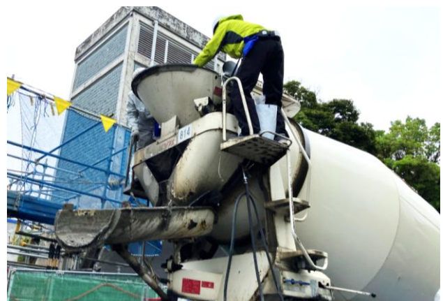
図－3 流動化剤の投入状況
