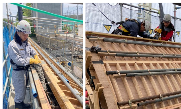
図-5 高流動コンクリートの打設状況
