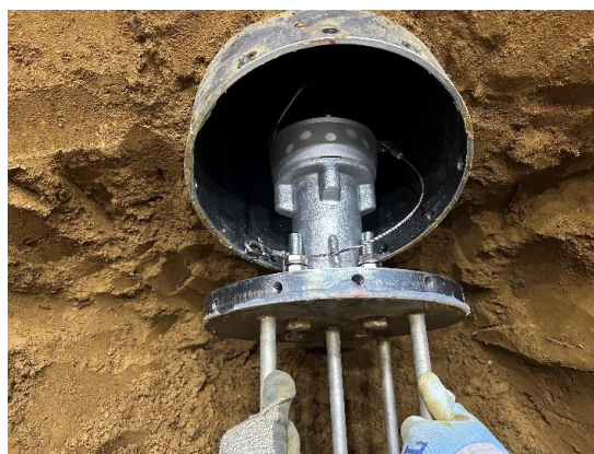
写真-2 載加盤およびエアノッカーの取付け
