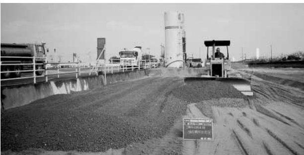
福岡県 地下鉄3号線車両基地作業所
