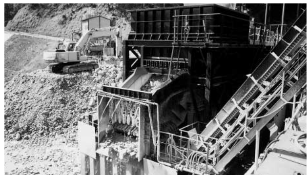
新潟県 青海トンネル作業所
