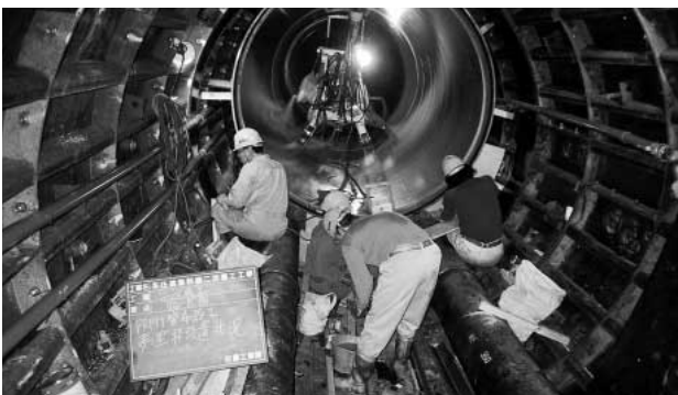
兵庫県 本庄シールド作業所
