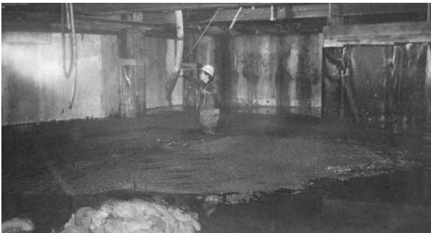
東京都 押上作業所
