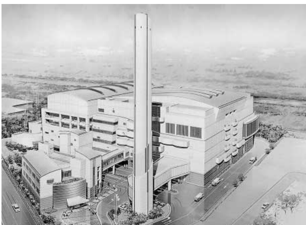
愛知県 猪子石作業所
