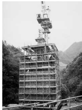
宮崎県 上岩戸作業所
