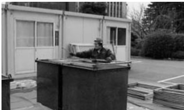
東京支店 内閣府作業所
