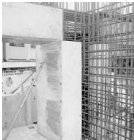
東京支店 立川曙町三丁目作業所
