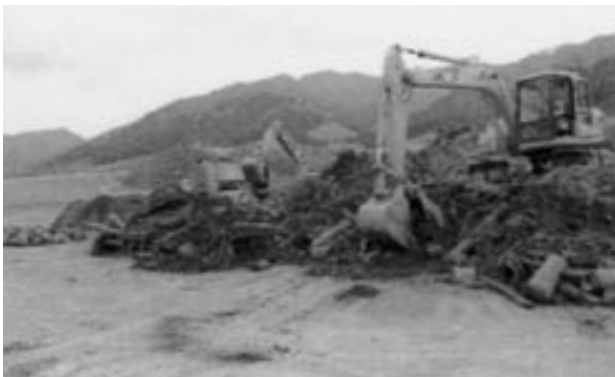
中国支店 苦田ダム作業所
