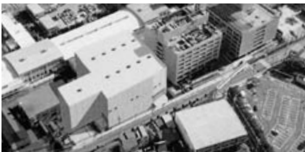
東京支店 臨海副都心線広町トンネル作業所
