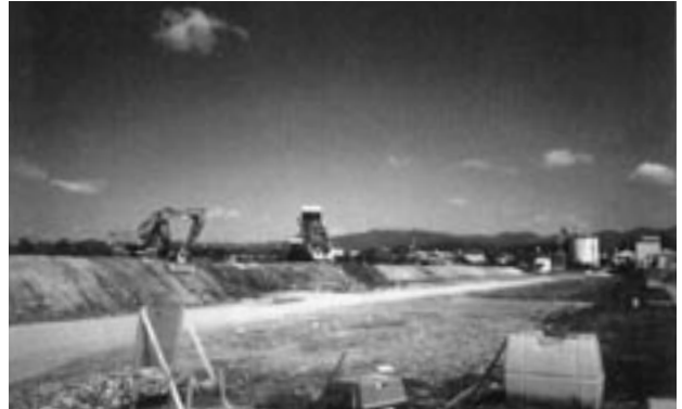
中国支店 津山シールド作業所
