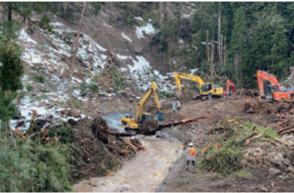
山田川河道復旧作業
