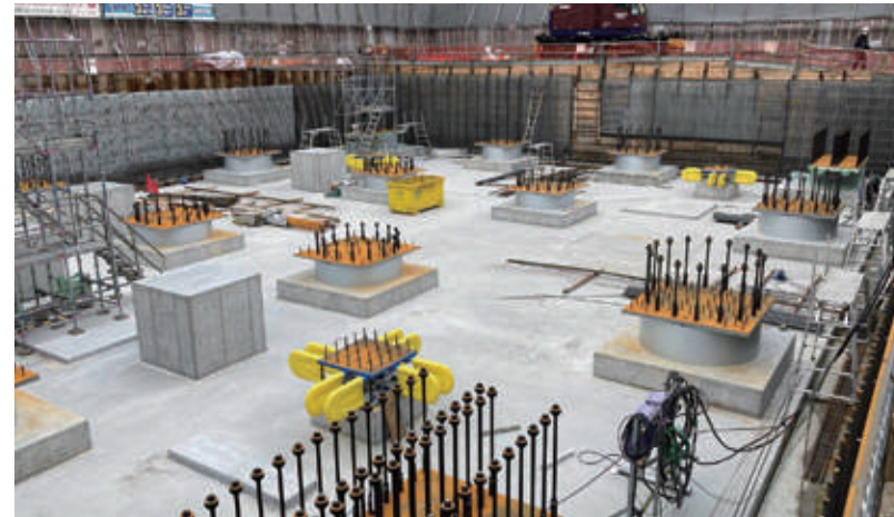
免震工事の様子
