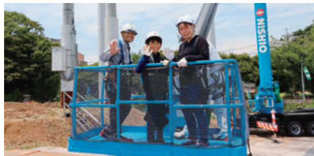
ヘルメットをかぶって高所作業車へ
