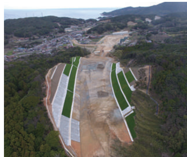
三隅・益田道路鎌手IC改良工事
