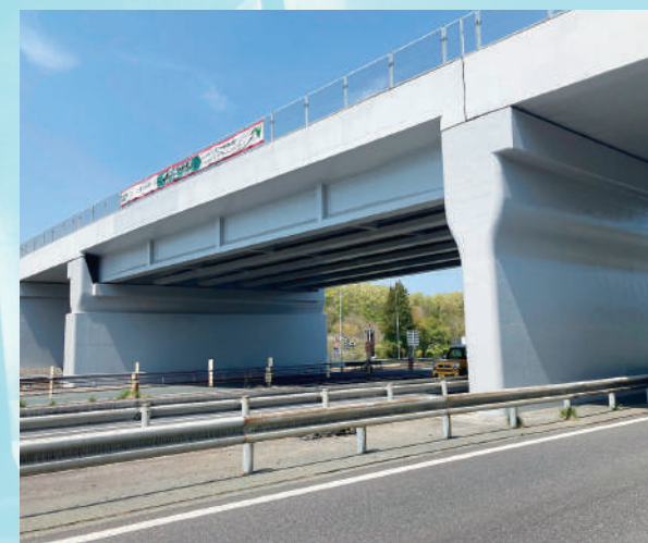
秋田自動車道 満屋橋耐震補強工事
