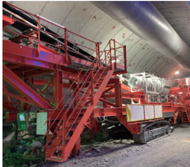
ベルトコンベヤ方式によるズリ搬出の様子
