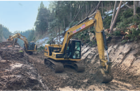
道路啓開作業(県道269号線)
