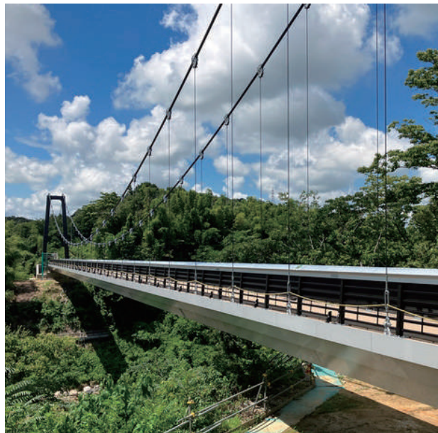
完成した呉羽丘陵フットパス連絡橋
