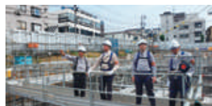
東京支店 高田馬場四丁目作業所
