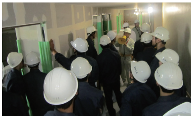
内装下地・仕上げ張りの見学(高岡工芸高校)
