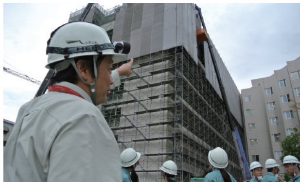
室内躯体壁解体を外から見学(富山工業高校)
