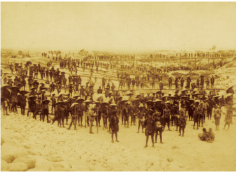
常願寺川改修工事(明治25年)
