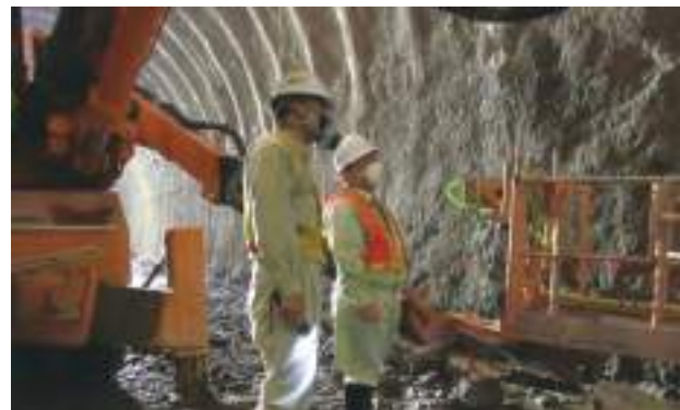
札幌支店 渡島トンネル（北鶴）作業所 安全パトロール
