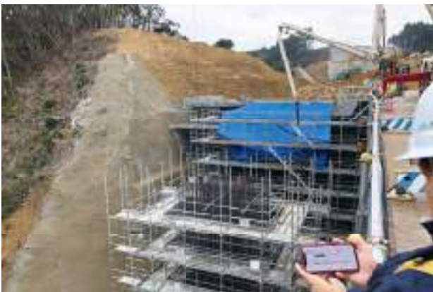
打設箇所から離れた場所でもスマートフォンで状況確認
