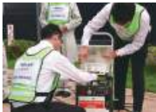
非常用発電機の使い方確認
