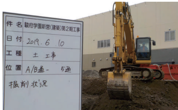
ICT建機による掘削状況
