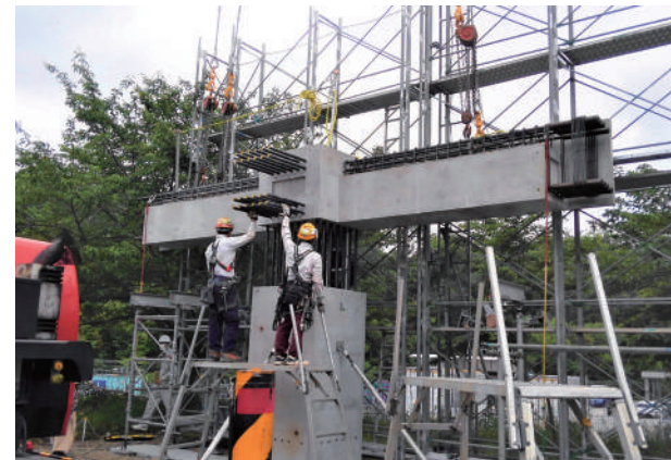
接合部PCa梁建方状況
