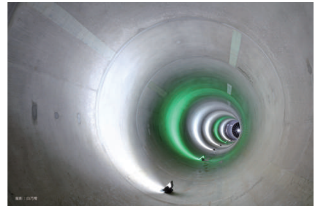
曲線部完成状況
