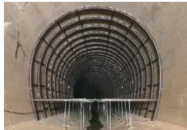
既設トンネル補強の支保工
