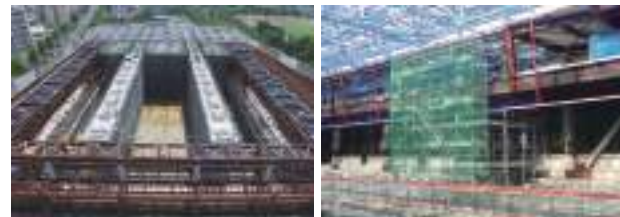
2列の支保工と3基の移動足場
