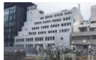
東京支店 日本橋本町四丁目作業所 安全パトロール
