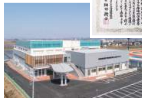
完成した平川市体育館(青森県)
