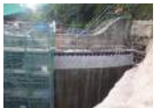
外観に配慮したEKウォール
