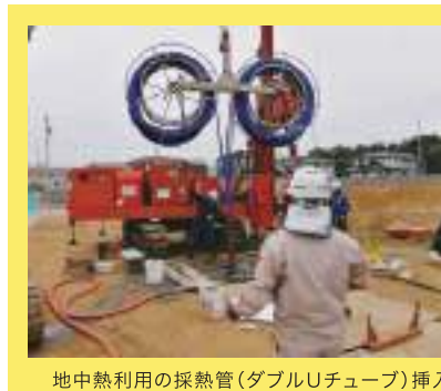
地中熱利用の採熱管(ダブルUチューブ)挿入
