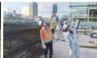
札幌支店 南2西3南西地区再開発作業所 安全パトロール
