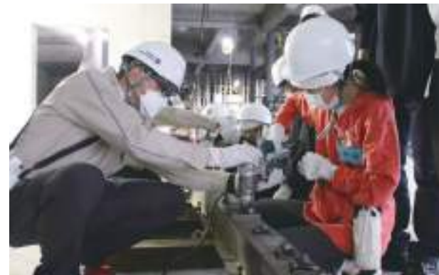
鉄骨の本締め作業を体験
