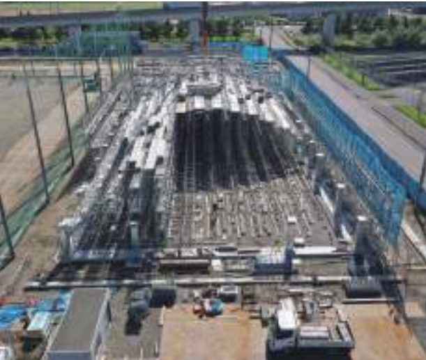
全面足場工法
