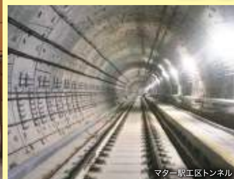
マター駅工区トンネル
