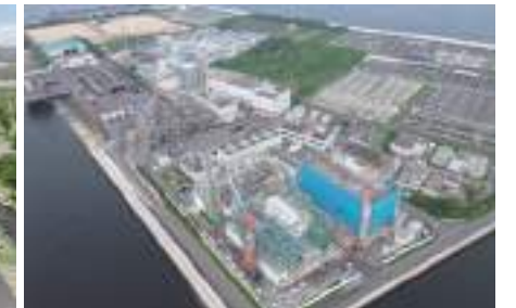
兵庫東流域下水汚泥広域処理場汚泥処理施設改築工事 (兵庫県尼崎市)
