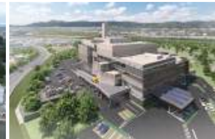
ゴミ処理施設整備・運営事業建設工事 (愛知県江南市)
