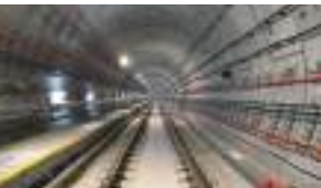
完成したアップパートムソン駅とシールドトンネル
