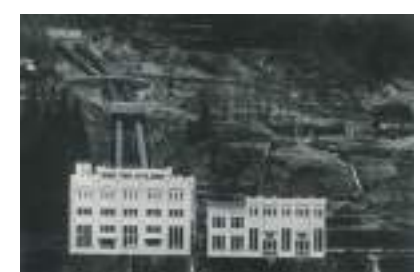
大同電力桃山水力発電所 1923(大正12)年竣工
