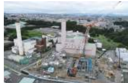
小山第2期エネルギー回収施設建設工事 (栃木県小山市)
