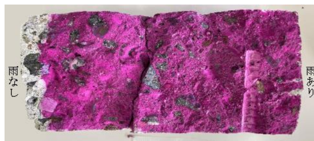
写真-3 No.2 の中性化状況
