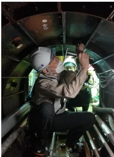
写真-7 セグメントの計測状況
