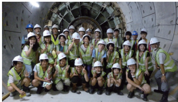
シールドトンネルの切羽にて
