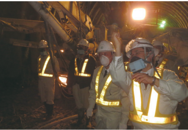
大阪支店 鍋谷峠トンネル作業所パトロール
