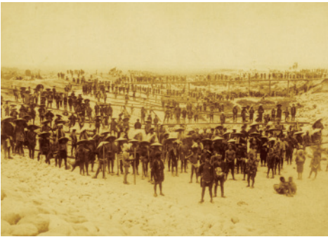
常願寺川改修工事(明治25年)
