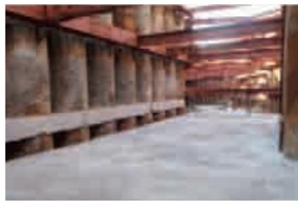
HVFCによる置換コンクリート打設状況
