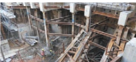
水平つなぎの設置
