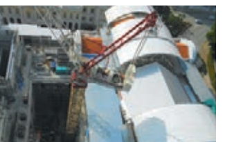
屋根テントと新設屋根
