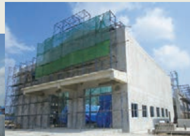
工事現況(中継施設棟)
