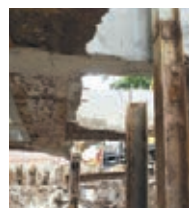
梁に支持された既存壁
