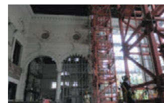
アーチ開口部の補強状況
