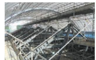
新設屋根鉄骨施工中
