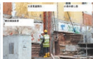
大梁・小梁の施工状況
