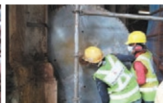
丸ノコによる壁切断
