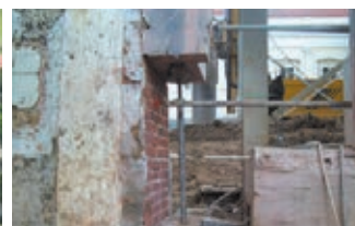
大梁貫通開口。外壁をワイヤーソーで切断
