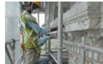
既存塗装除去
