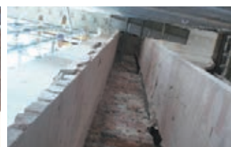
平滑な壁切断面
