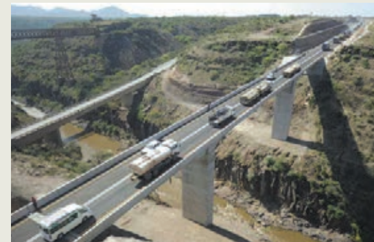
開通になったアワシュ橋。左は旧橋、その奥は旧鉄道橋
