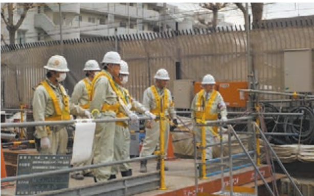
東京支店 金町作業所パトロール
