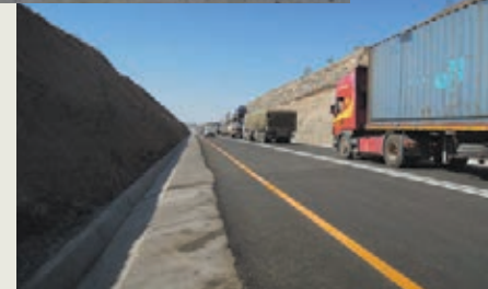
取付道路の状況
