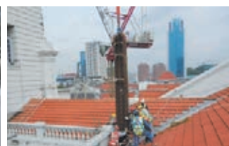
鉄骨柱建方状況
