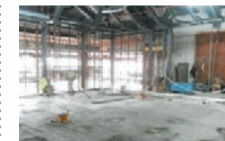
コンクリート打設
