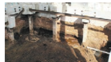
地下掘削開始
