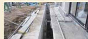
幅50cmの縁切り。ホール棟との接続部は、新規の柱に免震装置を設置後、既存柱・梁・壁を撤去
