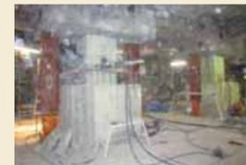
柱をワイヤーソーで上下切断
