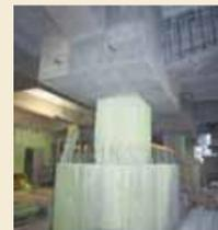
キャピタル(上部柱)鉄筋・コンクリート補強完了状況
