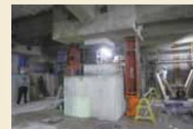
既存柱切断・引き抜き完了
