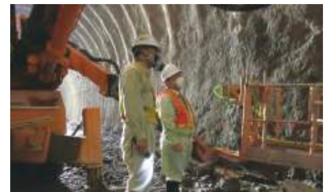
札幌支店 渡島トンネル（北鶴）作業所 安全パトロール
