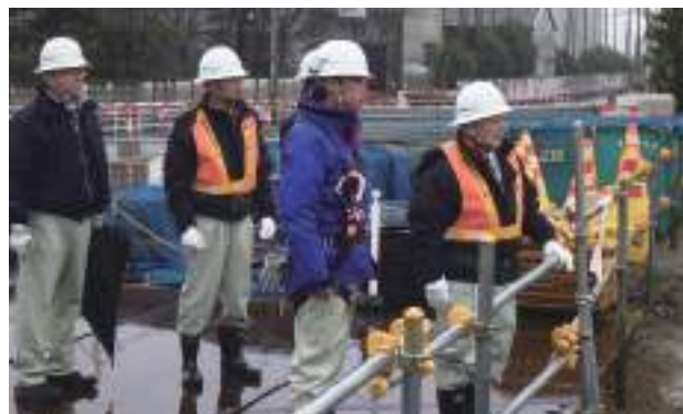
北陸支店 大島橋作業所 安全パトロール
