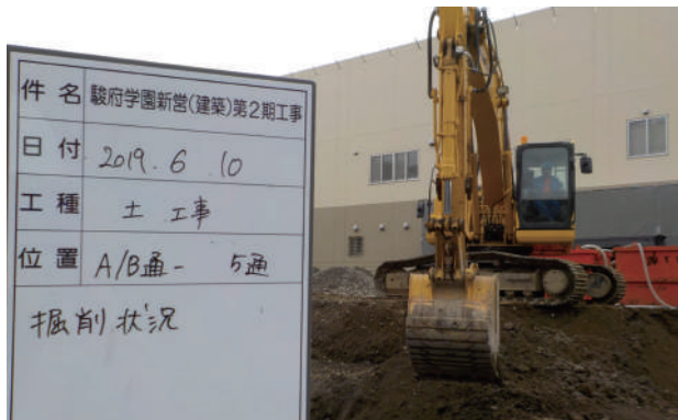
ICT建機による掘削状況
