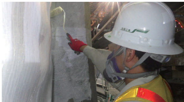
TT-4塗布状況
