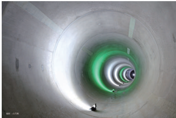
曲線部完成状況
