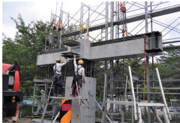
接合部PCa梁建方状況
