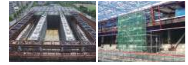
2列の支保工と3基の移動足場
