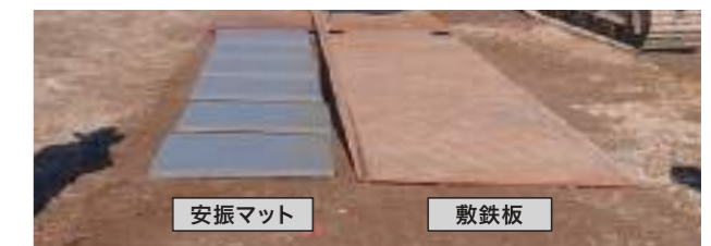
安振マットの敷設事例
