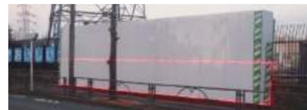
夜間通行時の接触事故防止として、仮囲いにチューブライトを設置
