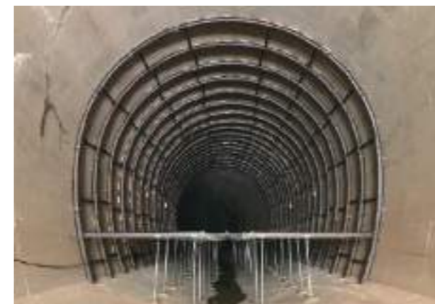
既設トンネル補強の支保工
