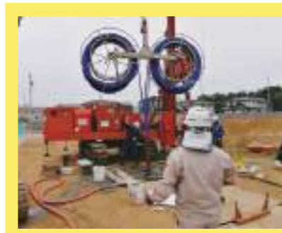
地中熱利用の採熱管(ダブルUチューブ)挿入
