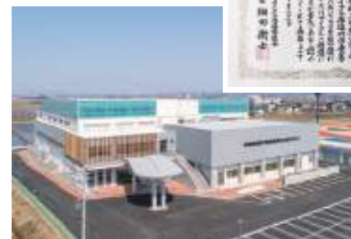
完成した平川市体育館(青森県)
