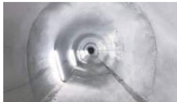
原町発電所新導水路
