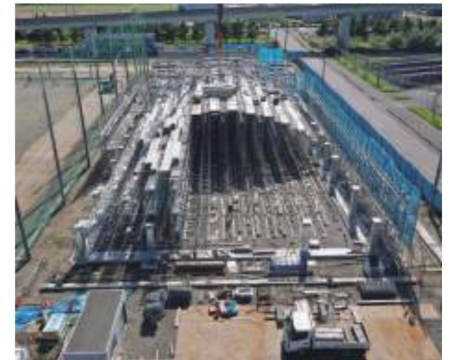
全面足場工法
