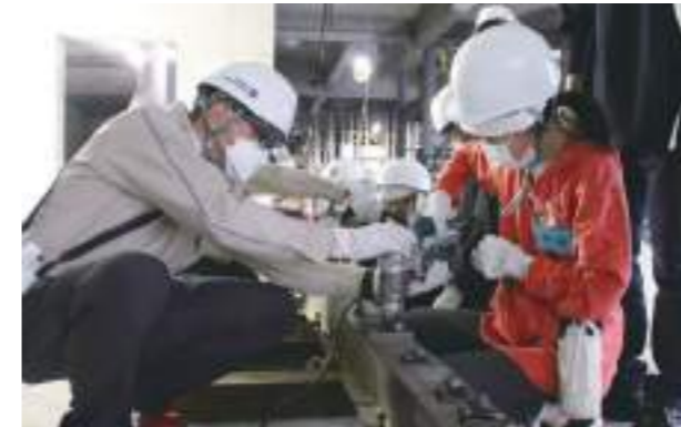
鉄骨の本締め作業を体験
