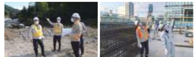
九州支店 小川内作業所 安全パトロール
