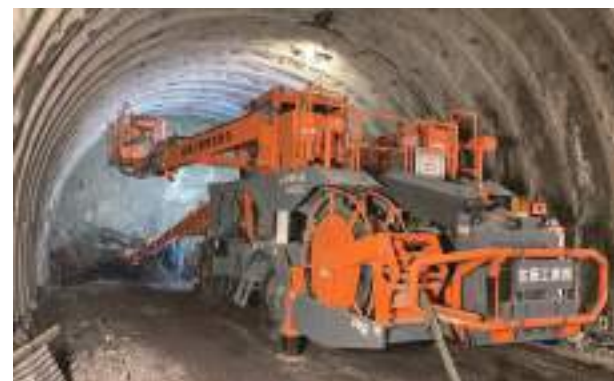
フルオートコンピュータジャンボによる掘削
