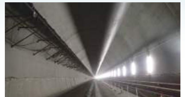
最新のシステムを駆使して施工
