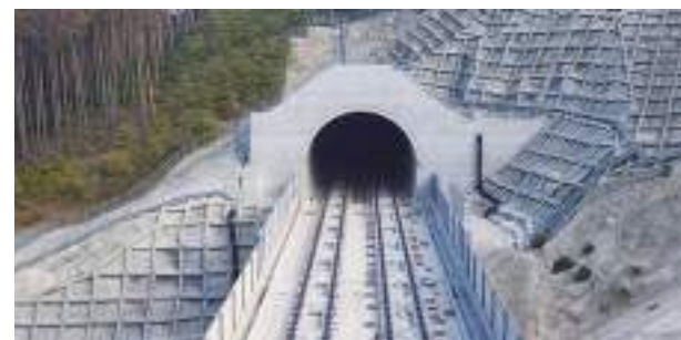
第1平山トンネル
