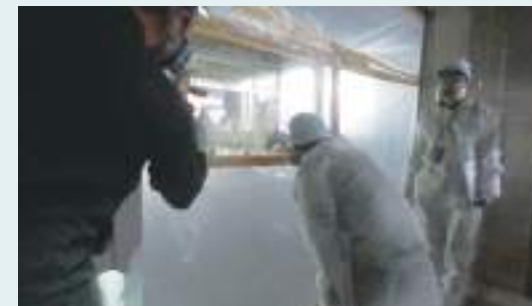
覗き窓から作業を見学
