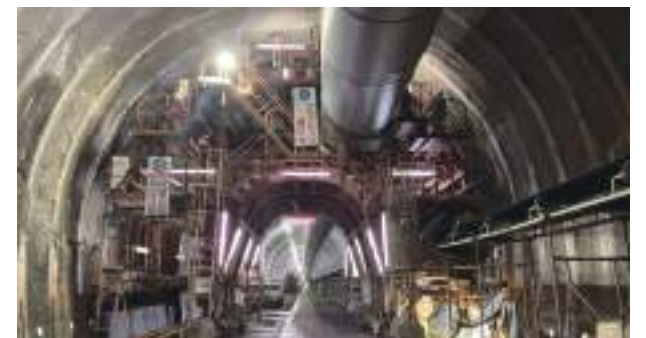
掘削方法を変更して施工
