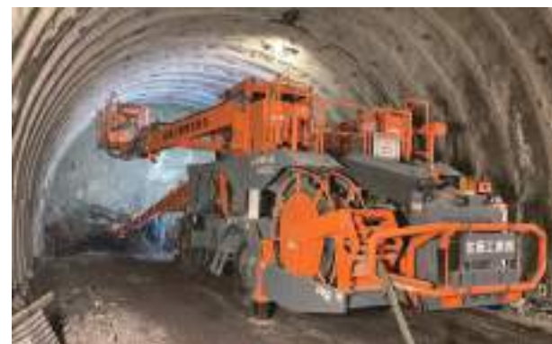
フルオートコンピュータジャンボによる掘削
