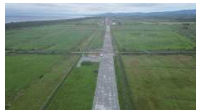
ゼロカーボンをめざして施工
