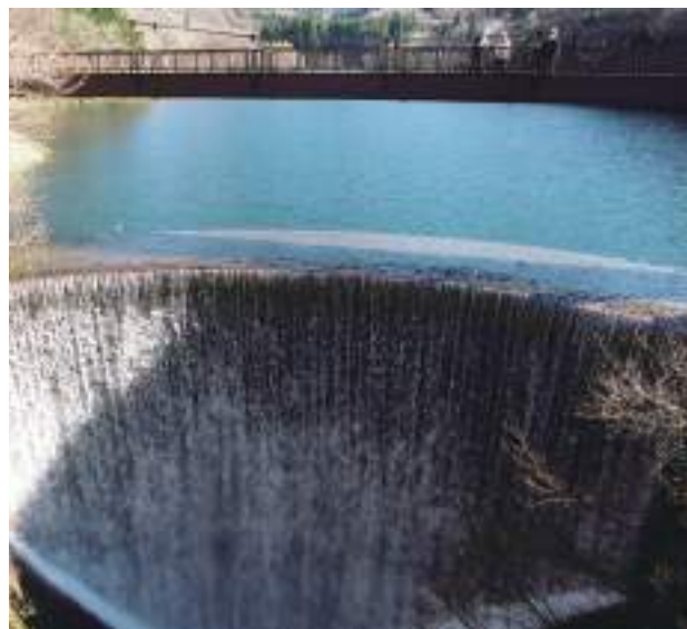
アーチ式の大源太川第1号砂防堰堤
