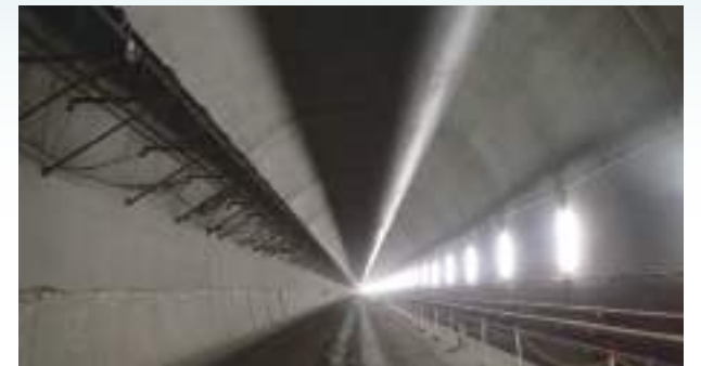
最新のシステムを駆使して施工
