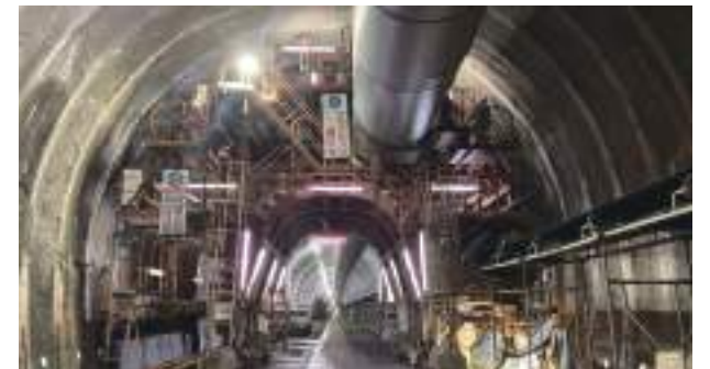
掘削方法を変更して施工
